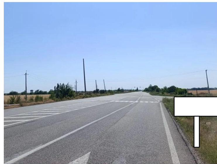
Автомобильная дорога М-18, с правой стороны перед поворотом на с. Новониколаевку
