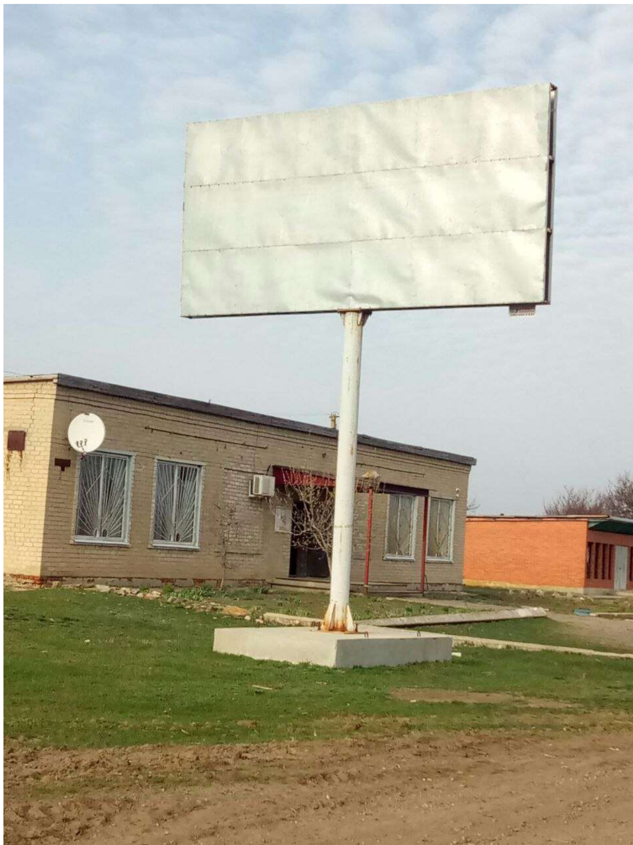
Фотоматериалы места установки РК № 26
