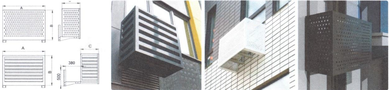
3) При размещении наружных блоков кондиционеров в корзинах/коробах на фасаде их необходимо размещать с привязкой к единой системе осей по вертикали и горизонтали и в соответствии со структурным членением фасада. Конструкция и рисунок перфорации корзин/коробов должны быть едиными в рамках всего здания, строения, сооружения. Окрашивание в соответствии с утвержденными цветовыми решениями для декоративных элементов фасада.
