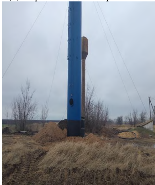
с. Дмитровка водонапорная башня
